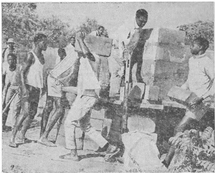
На строительстве нового дома в сельскохозяйственном кооперативе. Стройка осуществляется силами крестьян
